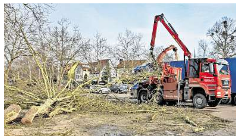
Ein 540 PS starker Holz-Schredder häckselte die für den Stegbau gefälltten Bäume im Anschluss klein. FOTO: DIETER GÜRZ
